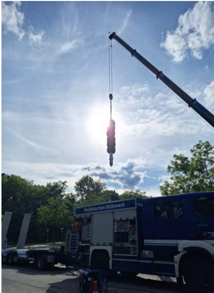
▲ Die Königskerze schwebend bei der Demontage am Sportplatz Mitterwöhr, Foto: Benedikt Schramm
